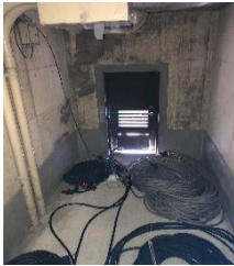
ケーブル処理室内 側より
