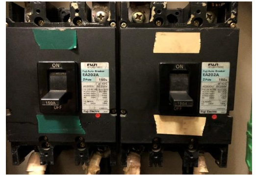
【遮断ブレーカー】
