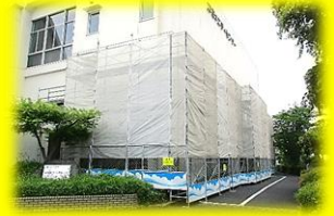
①外壁の様子
